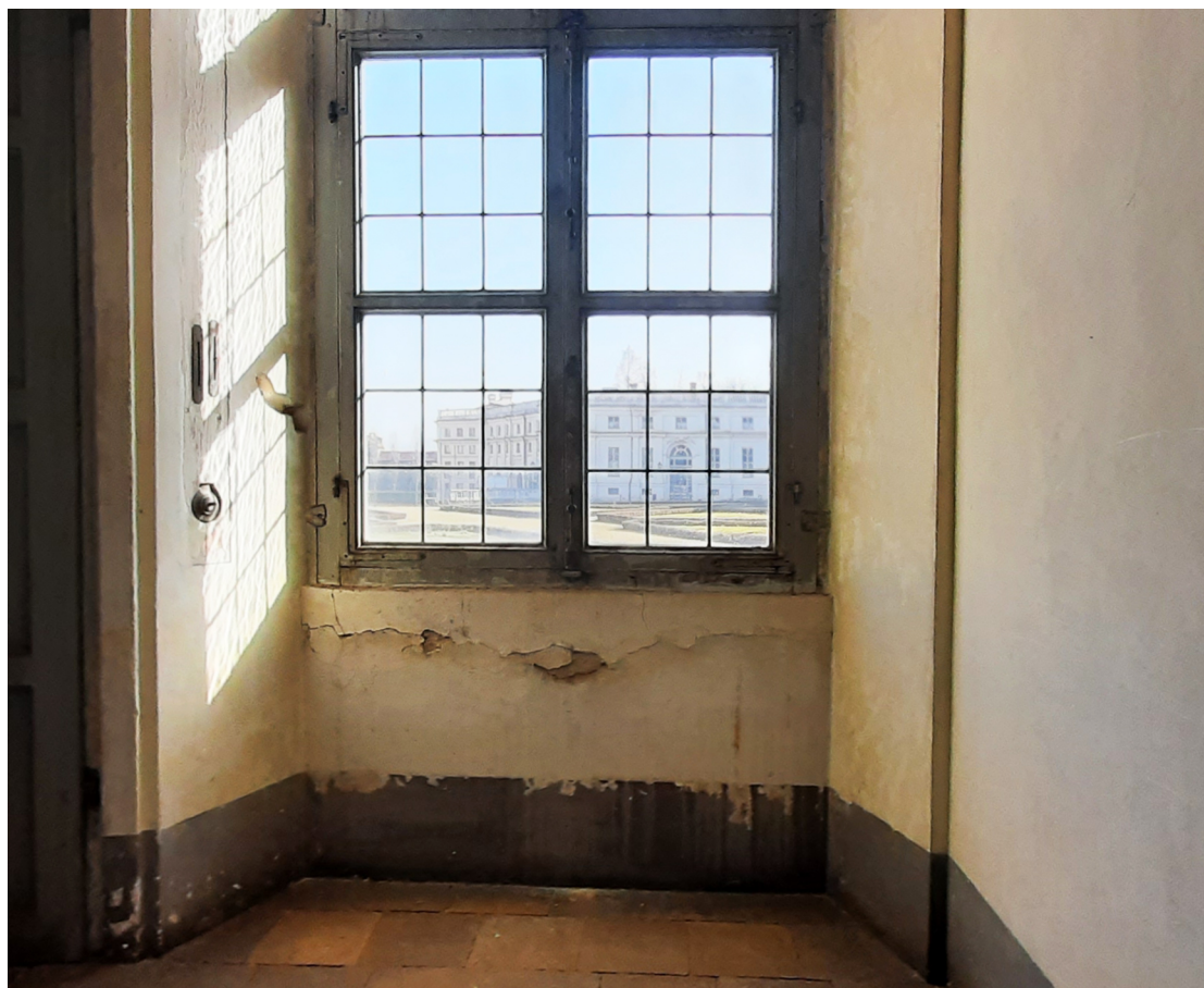
3. Scala juvarriana di ponente. Degrado delle superfici intonacate del pianerottolo
