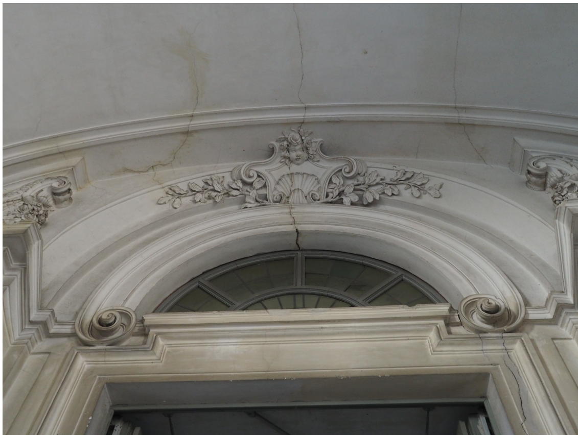
21. Galleria di ponente. Degrado delle superfici intonacate e in stucco
