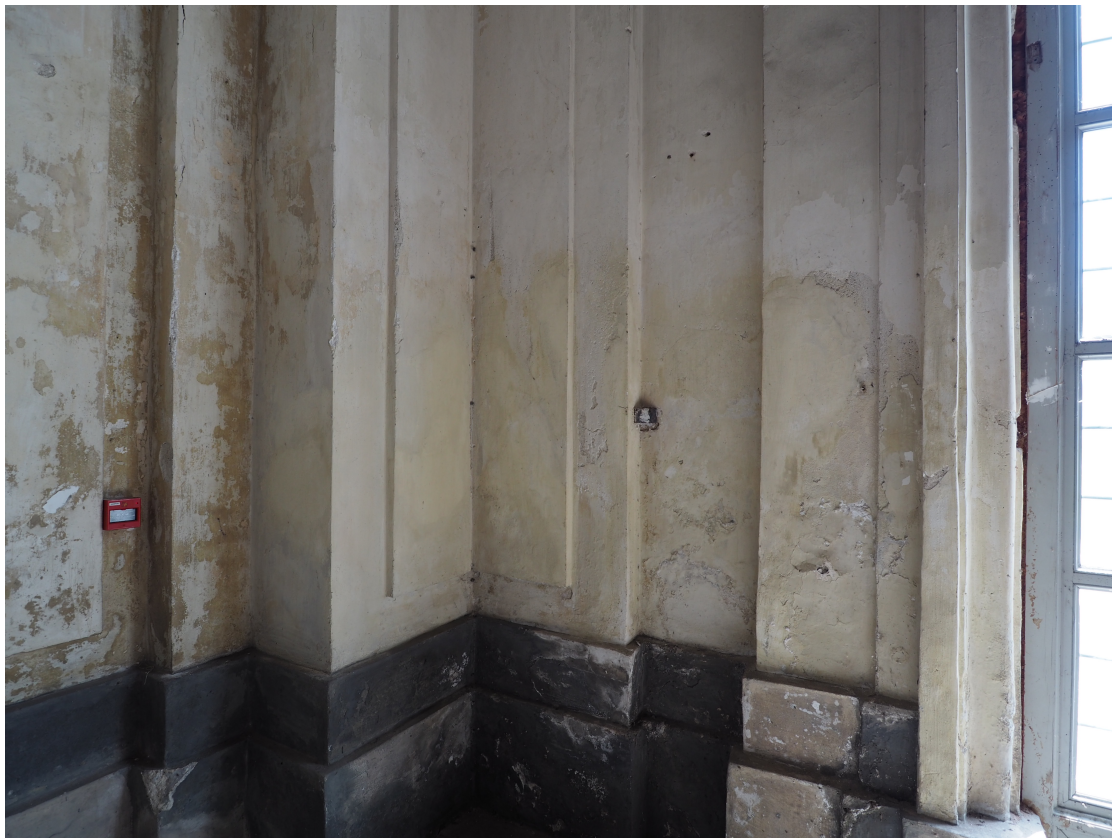
29. Atrio di ponente. Degrado dell'intonaco basamentale
