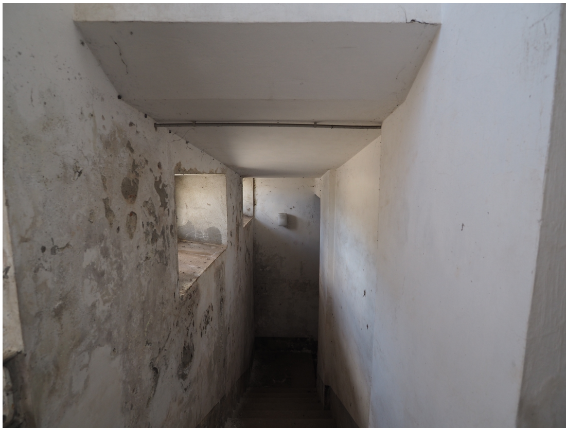
8. Scala juvarriana. Degrado dell'intonaco sulla rampa verso il piano seminterrato
