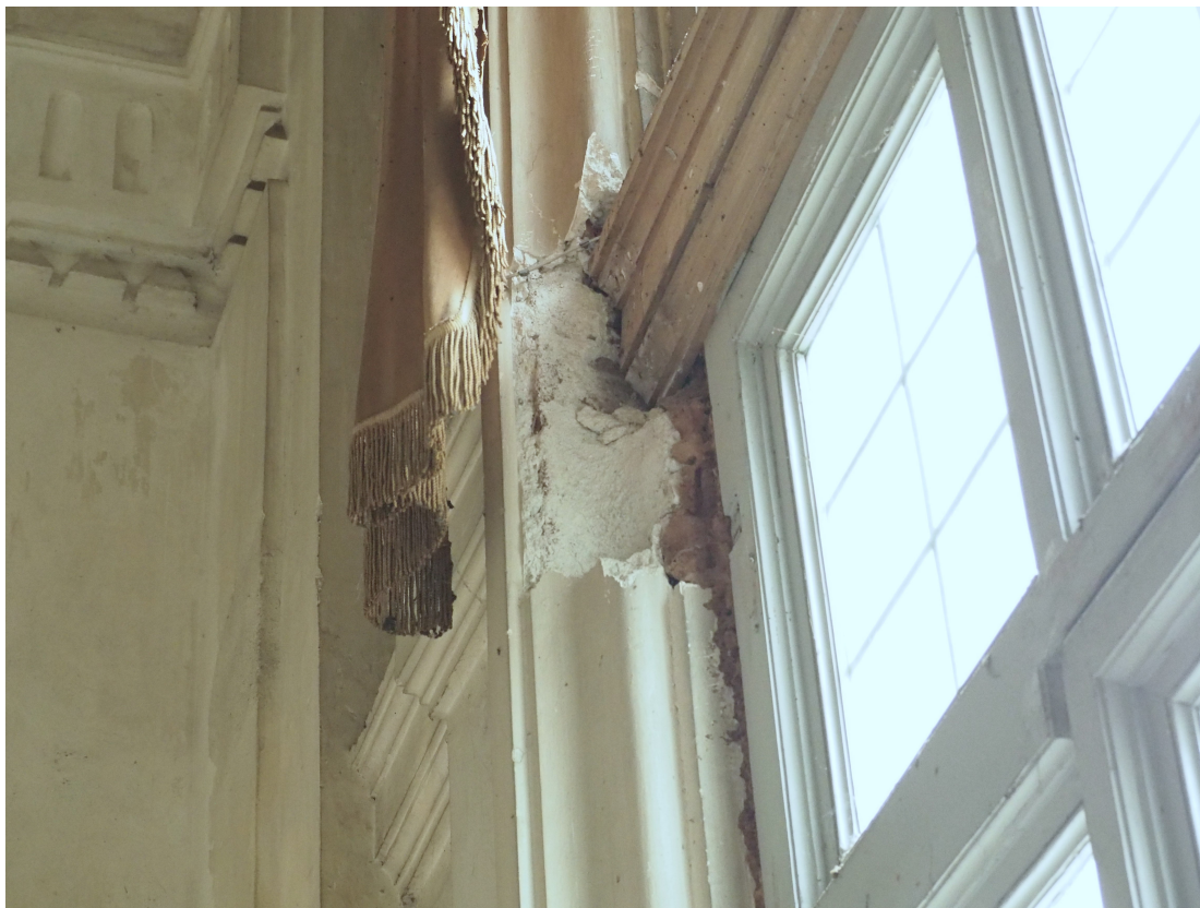
28. Atrio di ponente. Degrado delle cornici in stucco
