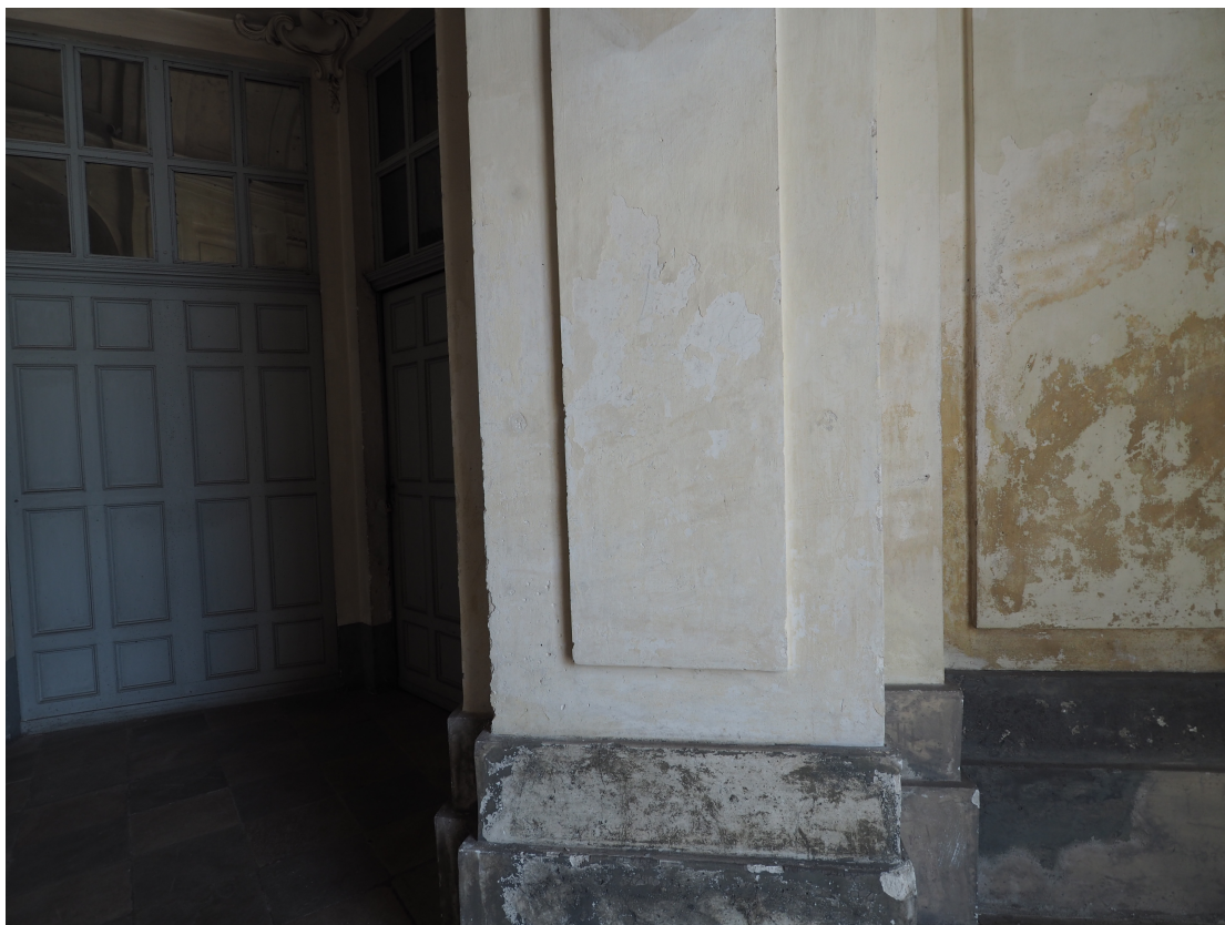
32. Atrio di ponente. Degrado della superficie intonacata.
