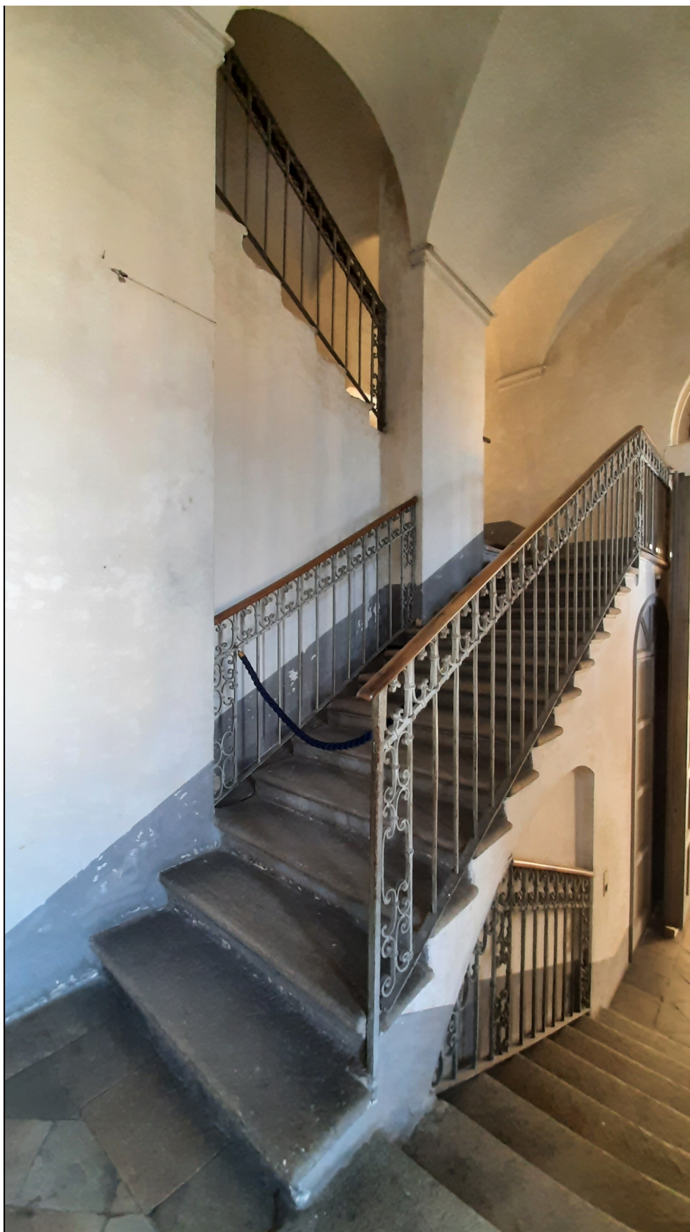
2. Scala juvarriana di ponente. Degrado delle superfici intonacate, della pietra e delle ringhiere, tamponamenti incongrui.
