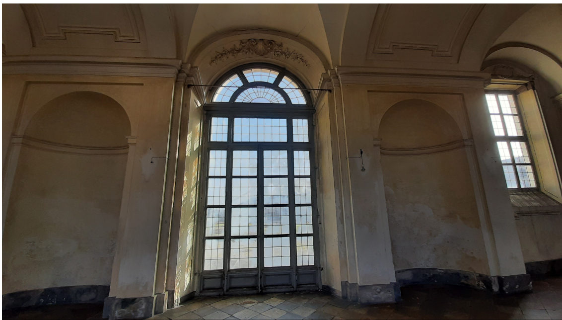
23. Galleria di ponente. Degrado degli intonaci della fascia basamentale e degli sguinci delle finestre
