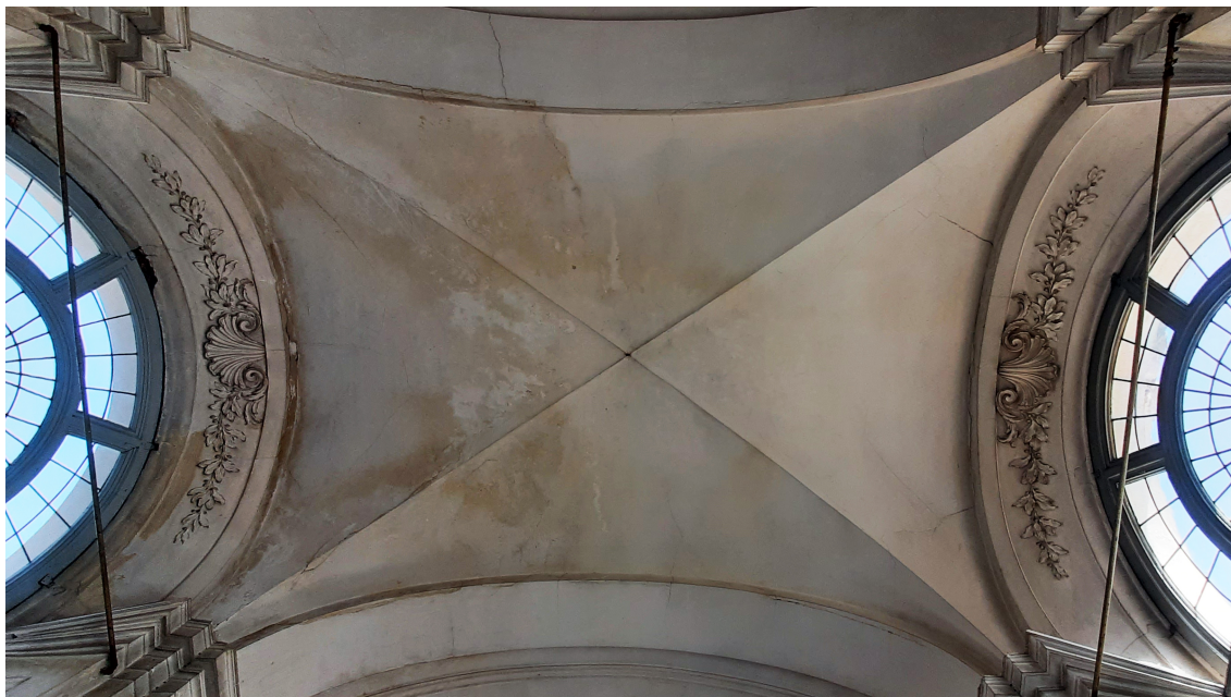
21. Galleria di ponente. Degrado delle superfici intonacate e in stucco
