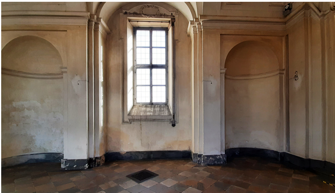
23. Galleria di ponente. Degrado degli intonaci della fascia basamentale e degli sguinci delle finestre
