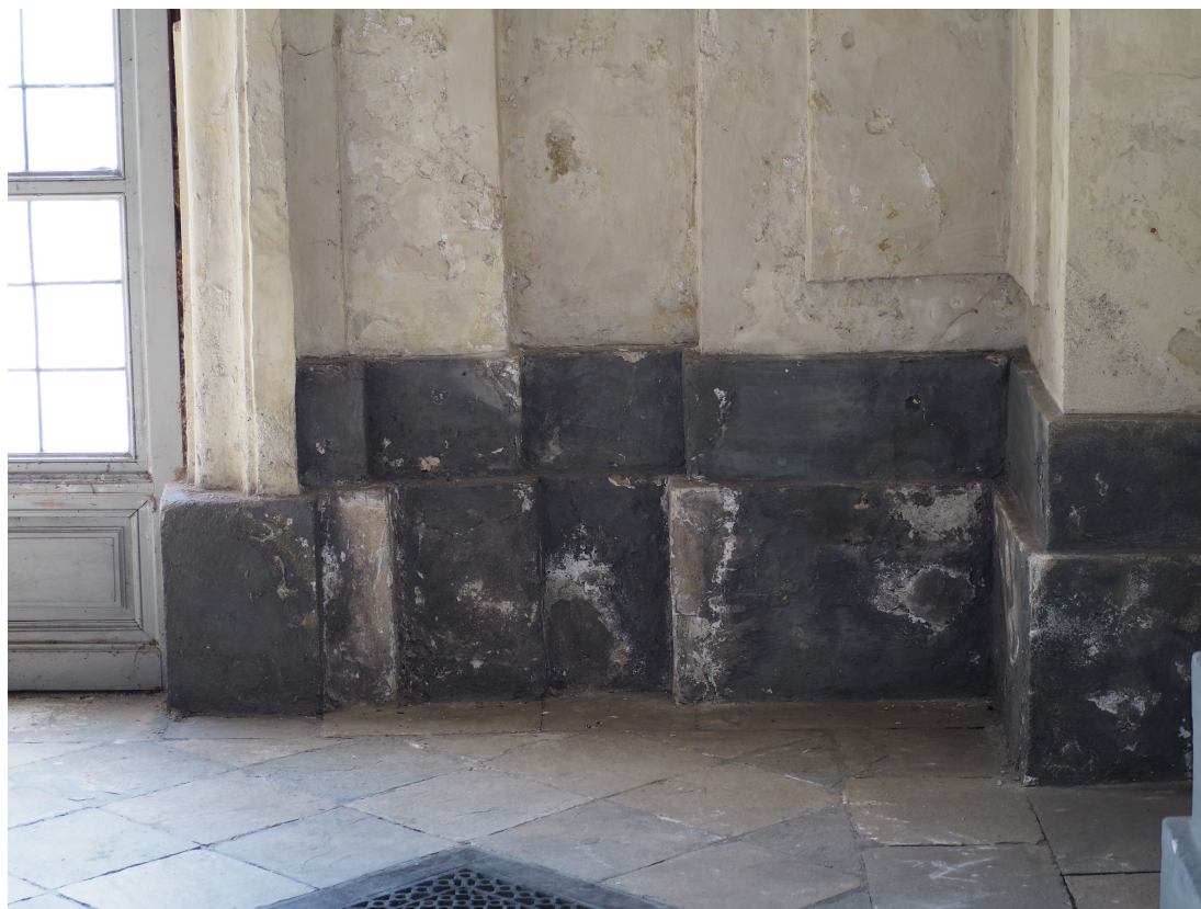
27. Atrio di ponente. Degrado delle superfici intonacate
